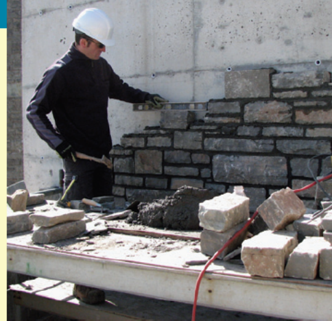
Jani Mroshaj utilise un niveau pour s'assurer que la pierre qu'il vient de placer dans ce mur est droite.
